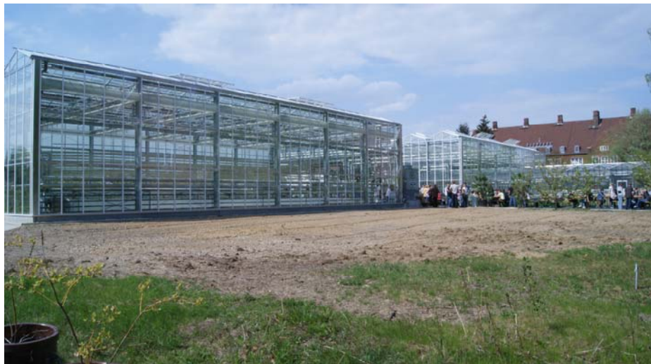
Feierliche Inbetriebnahme der ZINEG-Pilotanlage in Berlin-Dahlem
